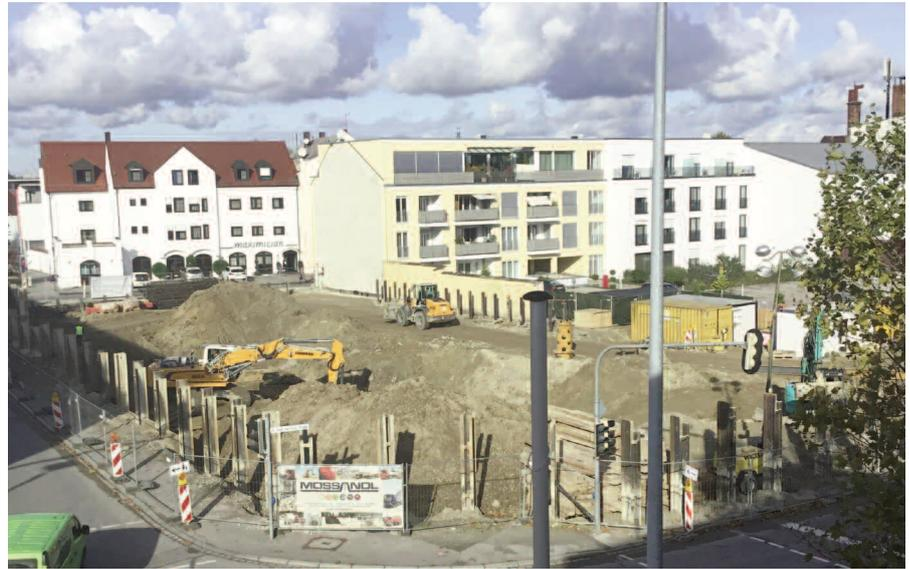
Laufende Arbeiten zum Baugrubenverbau- und Aushub.
